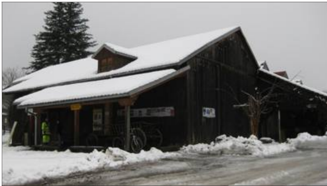
La Grange Burcklé va bénéficier de travaux de mise en conformité relatifs à l'accueil du public et aux sanitaires. Photo J-M.R.
