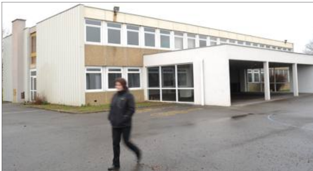
La Maison de la musique devrait être aménagée, dès cet été, dans les anciens locaux de l'école Jules-Renard. Elle accueillera les associations musicales, comme l'harmonie municipale Vogésia. Coût de cet investissement : 600 000 €. Photo Christophe Schmitt
